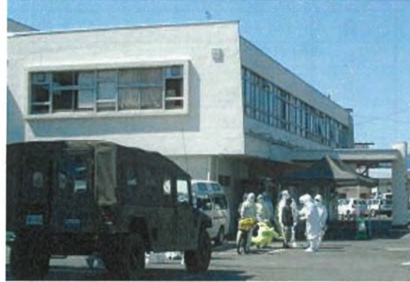
スクリーニングの状況 (平成 23 年 3 月 相双保健福祉事務所前)
