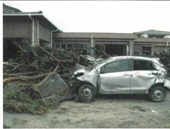
津波で被災した老健施設 (平成 23 年 3 月 南相馬市)
