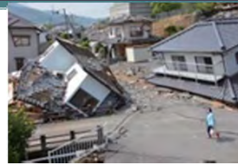
益城町の倒壊家屋
