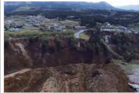
阿蘇大橋崩落現場
